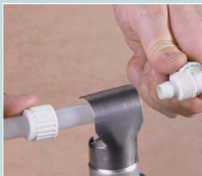
Монтаж пластиковых труб
