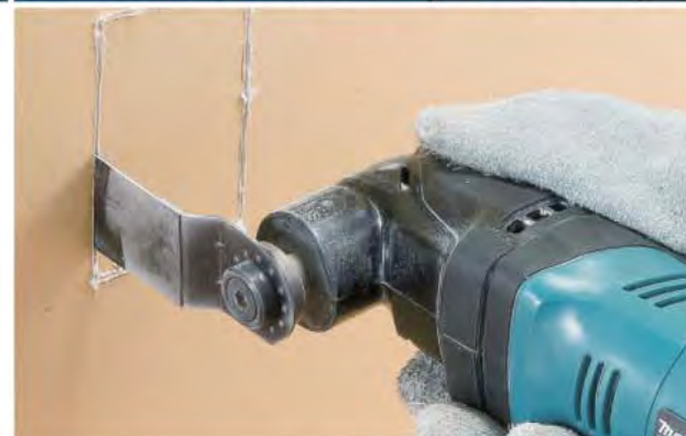
Резка гипсокартона
