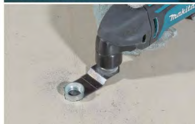
Резка металлических труб заподлицо
