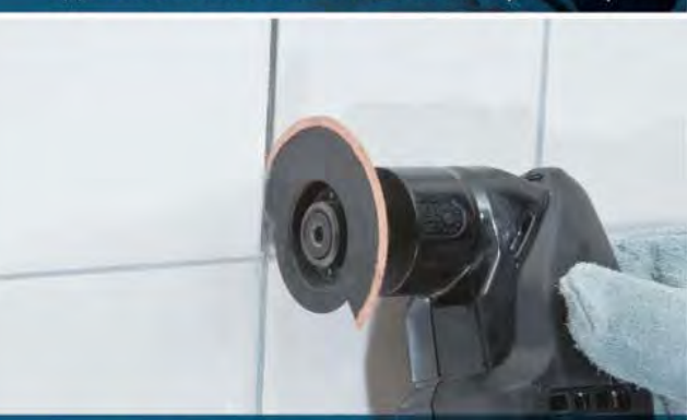
Очистка швов между плиткой
