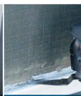
Удаление оконной э
