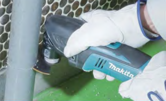
Резка труб из ПВХ и стеклопластика
