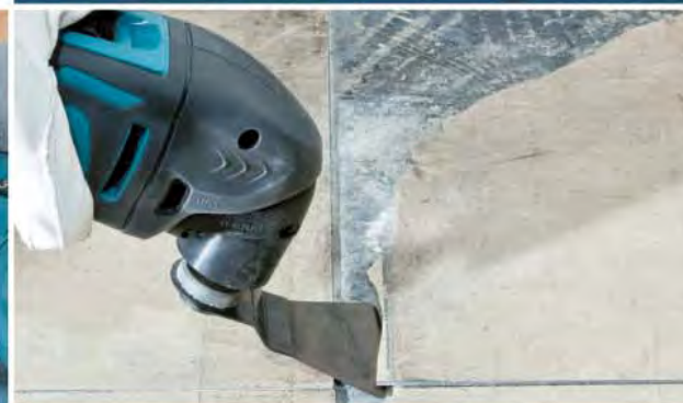
Удаление напольной плитки
